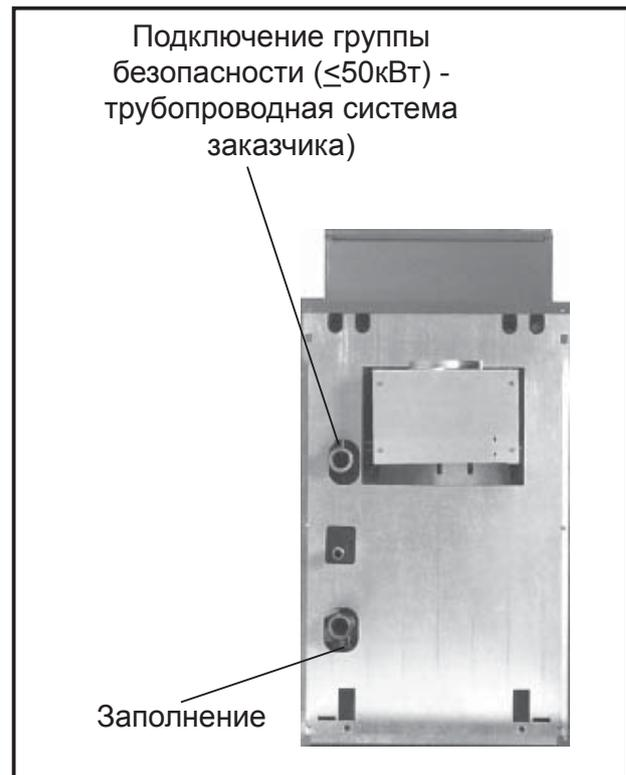
Рис.: Заполнение системы отопления
