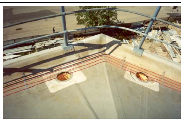
Рис. 5. Монтаж нагревательного кабеля deviflex™ DTIP-18 на крыше.
